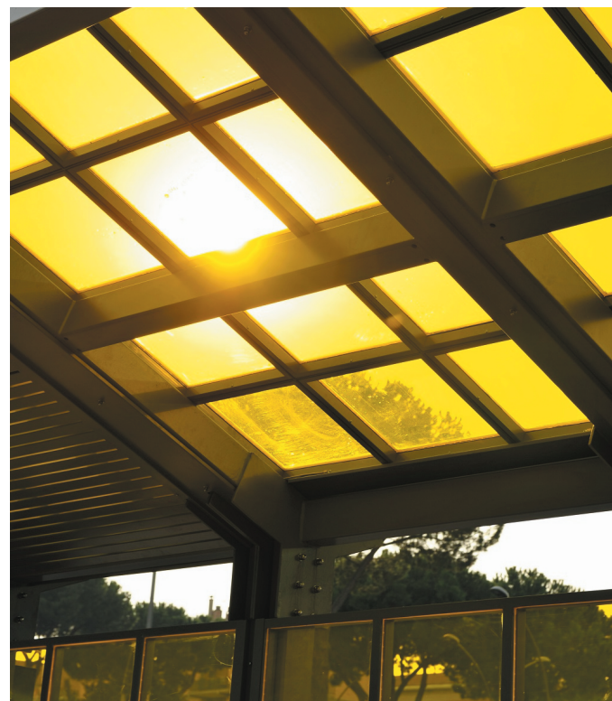
Pensilina Eni con le Smart Windows e, sopra, le lastre cattura-luce
